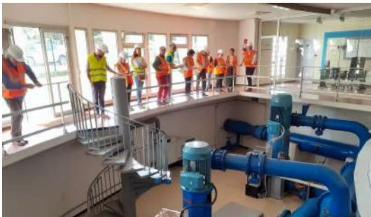
29.09.23 : visite des installation AEP de l'ARC
